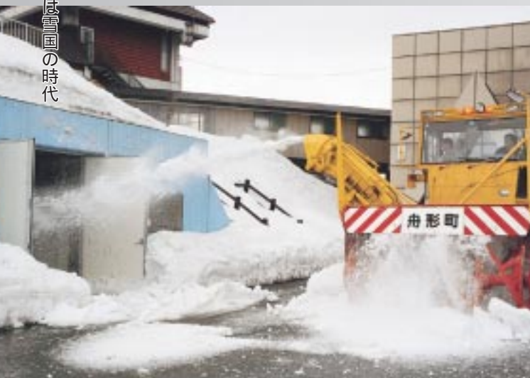
貯雪ピットへの雪入れ作業（60tの雪が入る）
