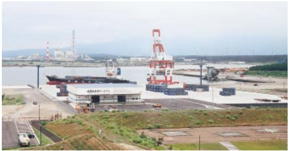
酒田港国際ターミナルの全景
