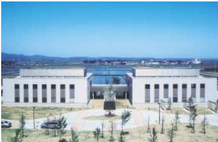
鶴岡市郊外の大宝寺字日本国に設置されたバイオラボ棟(実験実習施設)
