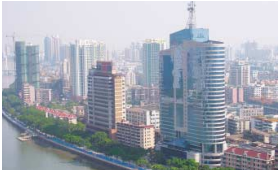
急開発が進む中国（広州市）
