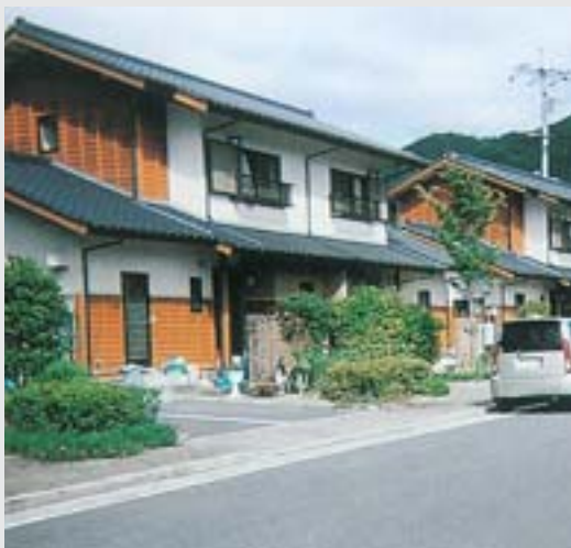
県産材を使い自然を取り入れた住宅
