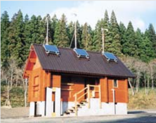
風力と太陽光のハイブリッド発電で金山町の「ねむのき広場」に設置したバイオマストイレ
