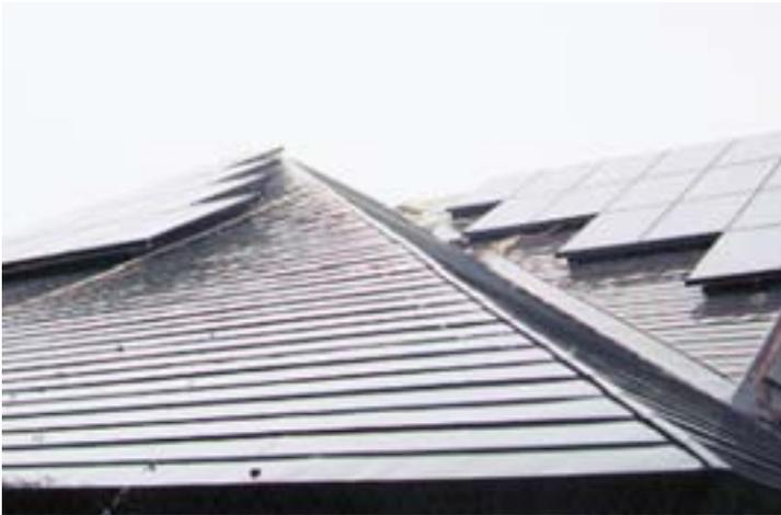
廃食油からせっけんを作る「NPO知音」の屋根に設置された太陽光を集めるパネル。南向きの屋根で傾斜はほぼ28度。
