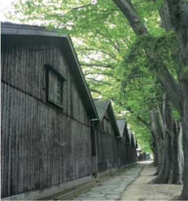
ケヤキ並木と一体化した山居倉庫
