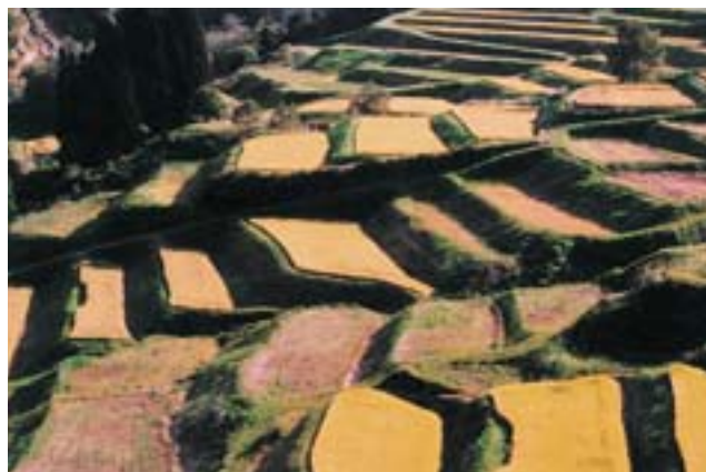
整然と管理されている大蔵村四ヶ村の棚田。ここは地滑り地帯なので、仮に棚田が耕作放棄されれば数年で土砂崩壊が起き、裾を流れる川がせき止められ大災害が発生しよう。
