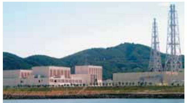
電源構造上ウエイトを高める原子力発電（女川発電所）
