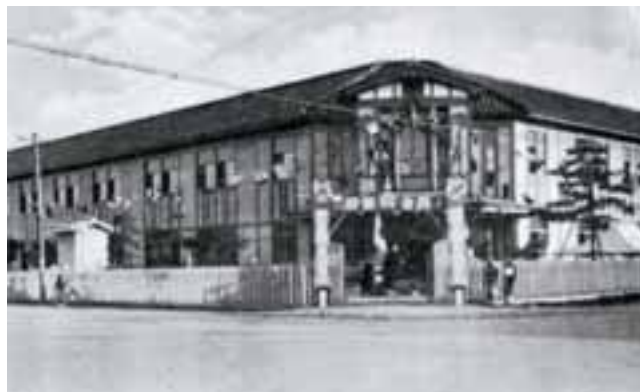
落成した新校舎（昭和10年）。校舎左側の出っ張り小屋は、住み込みの校務員室だと思われる（現在は存在しない）。出典：『生徒活動にみる八十年』（九里学園）
