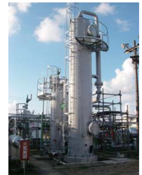
天然ガス生産設備
