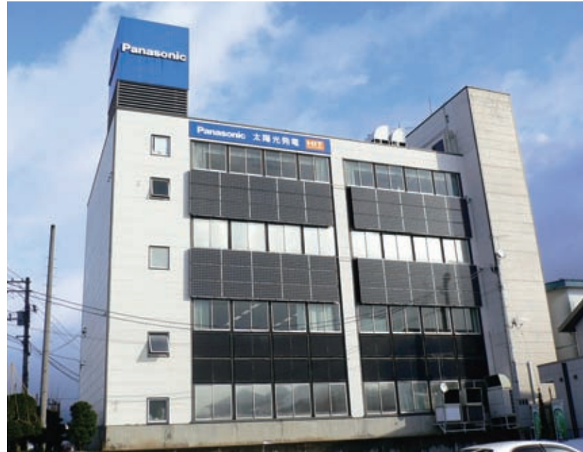
山形パナソニック本社壁面に設置された太陽光発電パネル。発電効率の実証試験を行っている。
