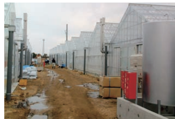
建設が進む「山元いちご農園」のハウス。 平成23年12月撮影。
