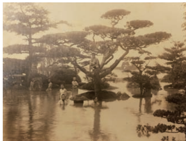
長山小路（今の鳥居町）に店舗があったころ、川の氾濫で庭が水没した。わざと人物にポーズを取らせたのは、当時のしゃれ心だろうか。写真所有：有限会社寛明堂
