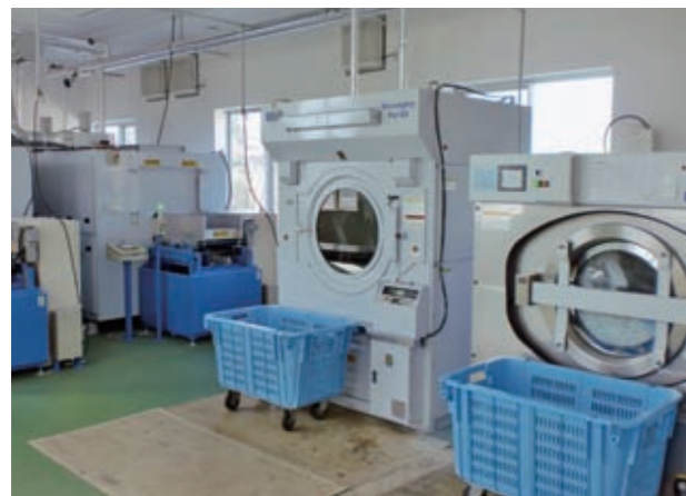
業務用のクリーニング機器が並ぶ工場内の様子
