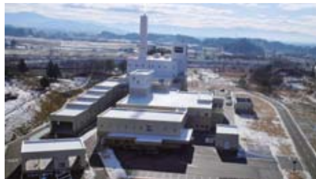
クリーンプラザよこて JV建築工事 2016(平成28)年3月竣工
