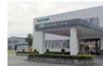
新庄中核工業団地内にある本社工屋
