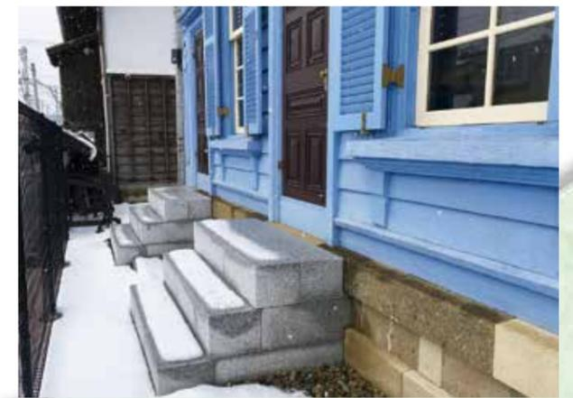
修理前、外部に面していた窓4カ所のうち2カ所は外扉だったと判明。石階段を設置するために建物全体を持ち上げて1m北へ移動した。（筆者撮影）
